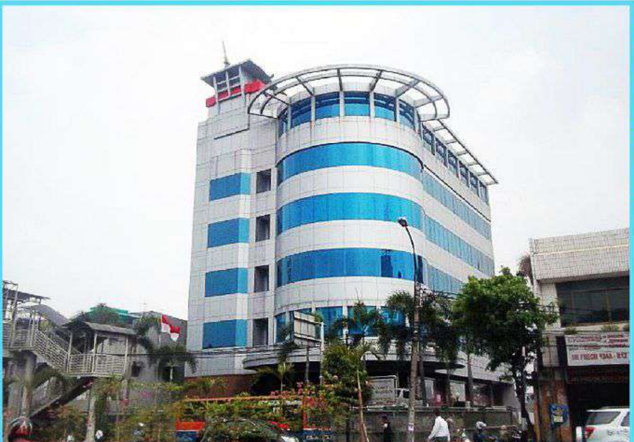
Graha BRINS Jalan Mampang Prapatan – Jakarta ( Pengawasan )
