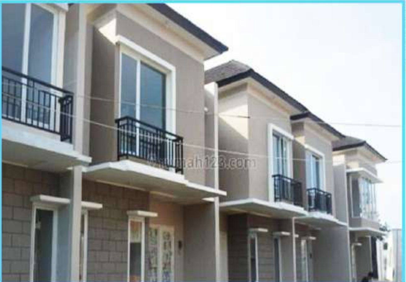
Perumahan Jade Park Serpong, Tangerang – Banten
